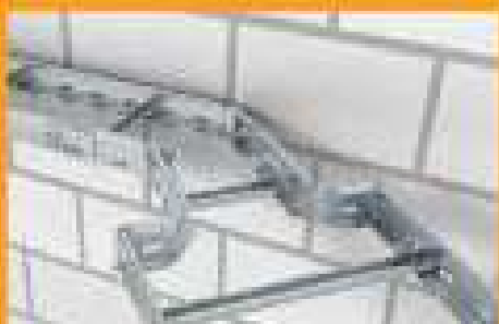
Łącznik wielofunkcyjny LMFV, na przykładzie redukcji symetrycznej.
