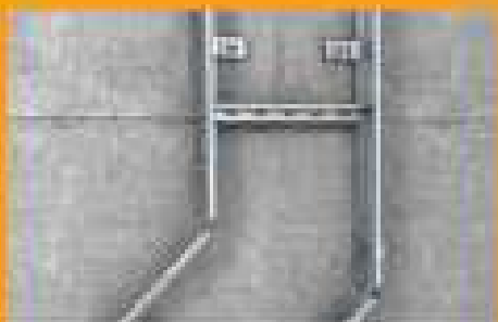
Montaż drabiny w pionie, bezpośrednio do ściany.
