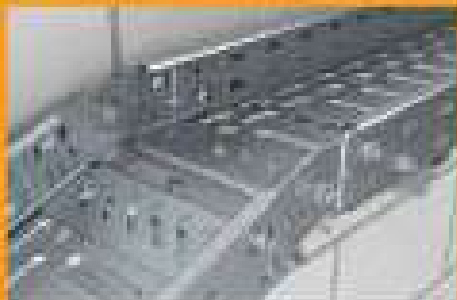
Zmiana poziomu, użyj łącznika przegubowego typu RGV.
