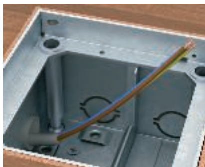
Przygotować przewód przyłączeniowy gniazda zasilającego Przygotować przewód przyłączeniowy dla gniazda zasilającego.
