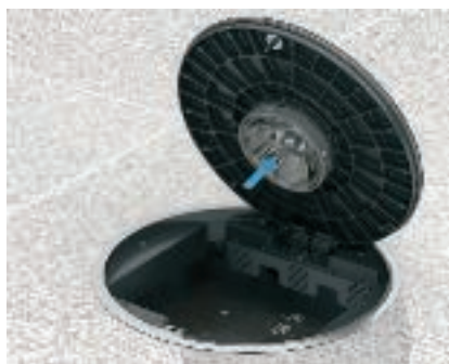
Podnoszenie tubusa Podnieść tubus używając przysawki i zablokować obracając go w lewą stronę.
