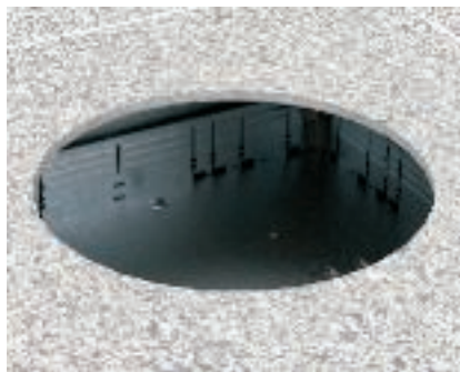
Ułożenie wykładziny podłogowej Wykładzinę podłogową ułożyć do otworu montażowego GRAF9.
