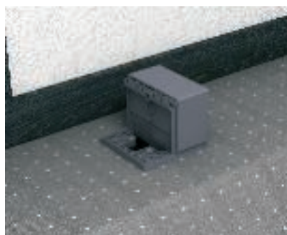
Montaż gniazd zasilających T4B i T12L Zastosować przegrodę do rozdzielania stron montażu gniazd zasilających.
