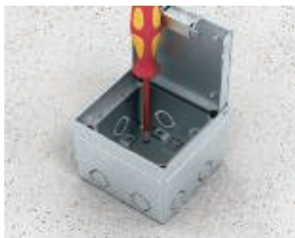
Montaż na konstrukcji nośnej Zamocować kasetę zasilającą na konstrukcji nośnej.
