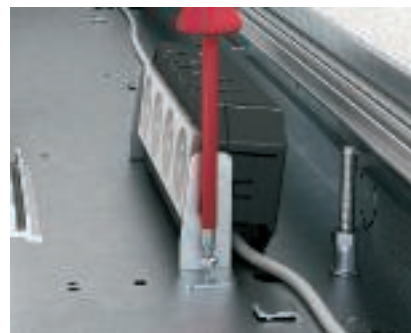
Montaż puszkii instalacyjnej i wspornika montażowego na spodzie kanału Po podłączeniu osprzętu elektroinstalacyjnego zamontować wspornik urządzeń na puszcze instalacyjnej lub wsporniku montażowym. Kompletną jednostkę przykręcić do podstawy kanału.
