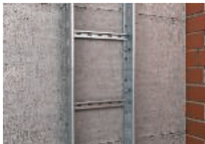
Bezpośredni montaż drabin pionowych na ścianie
