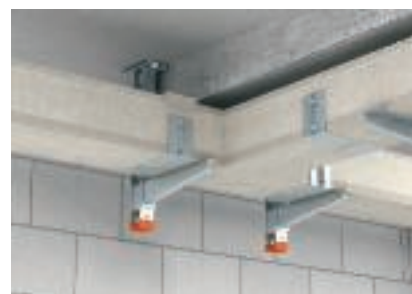
Zmontowane wstępnie kształtki w przebiegu trasy
