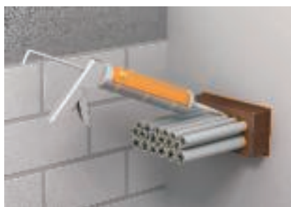
Końcowe wypełnienie spoin przy całkowitym wypełnieniu kablami
