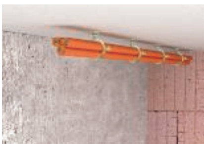
Układanie kabli w wiązkiach pod sufitem
