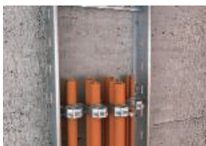
Pojedyncze mocowanie kabli lub w wiązkach za pomocą obejm kabłkowych
