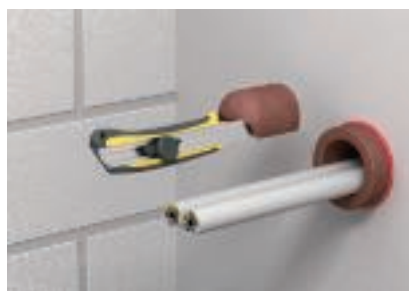
Przycięcie i włożenie zatyczek w płaszczu rurowym
