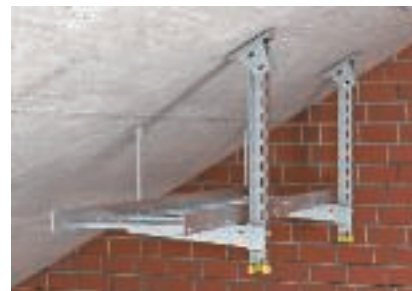
Montaż pod skośnym sufitem z głowicą regulowaną
