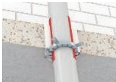
Montaż po dolnej stronie stropu za pomocą kołków stalowych
