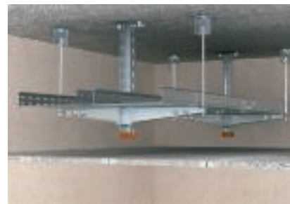
Dwuwarstwowe podwieszenie sufitowe z obustronnym montażem wsporników
