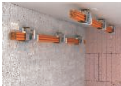
Montaż obejmy zbiorczej 2031 M 15 z waniemką wzdłużną
