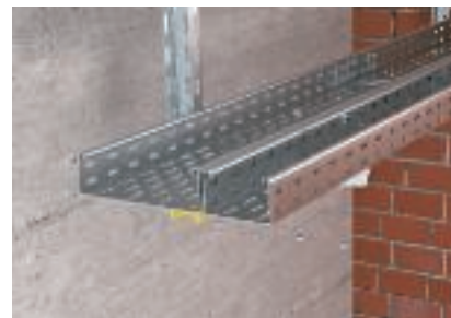
Montaż 2 koryt kablowych razem na wsporniku
