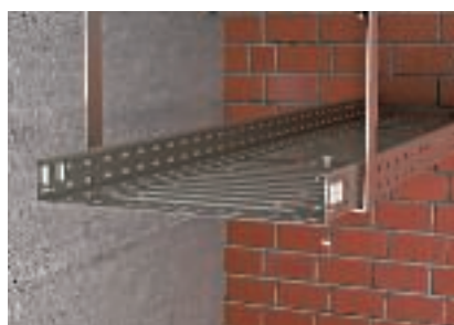
Mocowanie koryta kablowego za pomocą śrub z łbem grzybkowym
