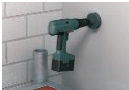
Wiercenie otworu otwornicą do pu-szek
