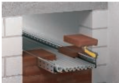
Montaż przyciętych bloczków
