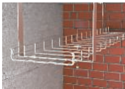
Mocowanie korytka siatkowe-go za pomocą zacisku i śrub grzybkowe-nych
