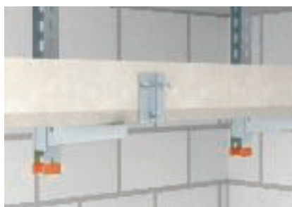
Bezpieczne łączenie miejsc styku przez przykręcanie zamontowanych wstępnie okuć
