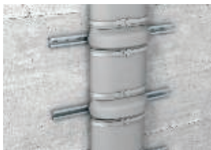
Mocowanie bandaży za pomocą taśm metalowych z naciągami przy instalacji kabli na szynach
