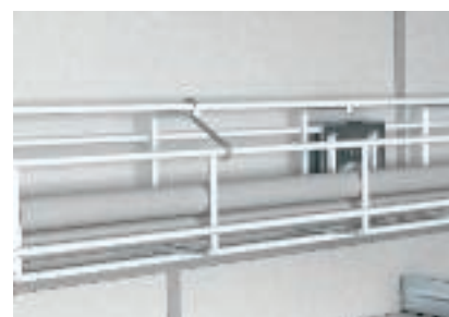
Hak zabezpieczający w prawidłowej pozycji
