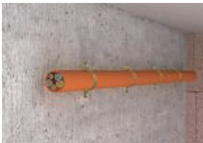
Poziomy montaż kabli na ścianie
