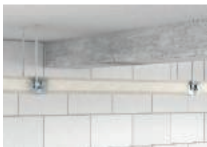
Podwieszany montaż na elementach łączących
