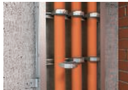
Instalacja kabli za pomocą obejm kabłkowych na szczeblach drabin pionowej
