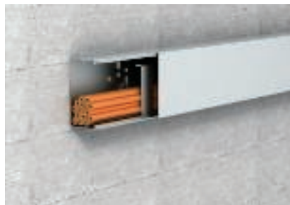
Układanie kabli zasilających, teleinformatycznych i sygnalizacji pożarowej w kanale typu LKM60100
