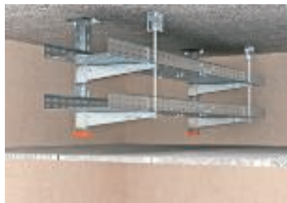
Dwuwarstwowe podwieszenie sufitowe z jednostronnym montażem wsporników
