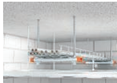
Wymagany odstęp minimalny od stropu przeciwpożarowego
