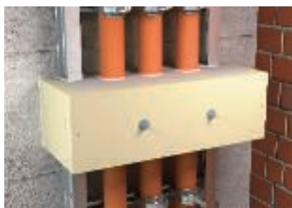
Skuteczne działanie wspierające przy użyciu odciążenia ciągu ZSE90
