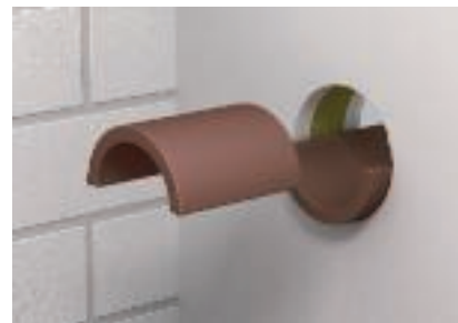
Montaż płaszczu rurowego w lekkiej ścianie działowej.
