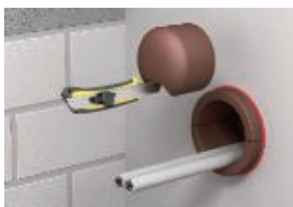
Przycięcie i zamontowanie zatyczek w płaszczu rurowym
