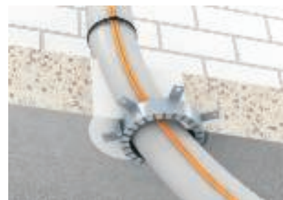
Instalacje poczty pneumatycznej z 2 dodatkowymi kablami
