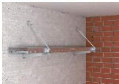
Montaż ścienny z zabezpieczeniem prętem gwintowanym skośnie
