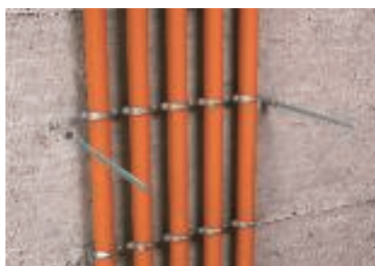
Punkty mocowania obok kabli bezpośrednio na ścianie
