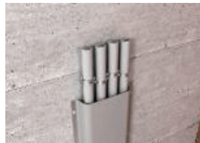
Mocowanie bandażu za pomocą metalowych szyn przy instalacji pojedynczo prowadzonych kabli
