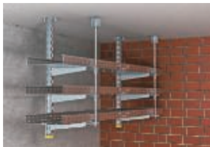
Podwieszenie sufitowe z jednostronnym montażem wsporników
