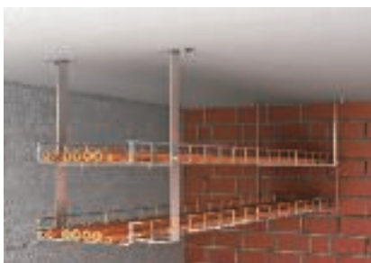
Dwuwarstwowy montaż sufitowy za pomocą uchwyty podwieszane-go i przedłuże-nia
