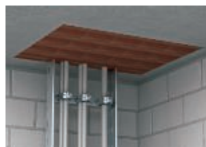
Ścisły montaż bloczków w stropie
