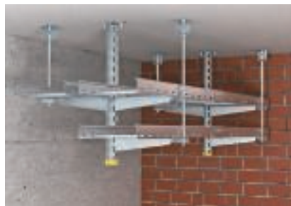
Podwieszenie sufitowe z dwustronnym montażem wsporników
