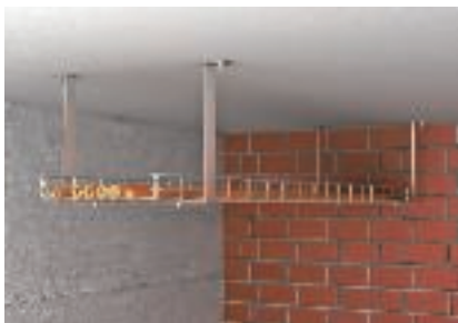
Jednowarstwowy montaż sufitowy za pomocą uchwyty podwieszane-go
