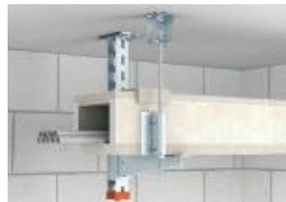
Montaż jako kanału E z dodatkowym zabezpieczeniem prętem gwintowanym
