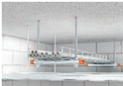
Jednowarstwowy montaż sufitowy nad podwieszanym stropem przeciwpożarowym
