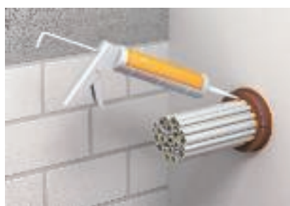
Wypełnić pozostałe spoiny masą szpachlową FBA-SP w przypadku całkowitego zapełnienia otworu
