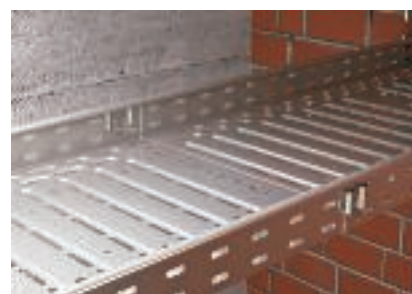
Wykonanie połączenia bez dodatkowych śrub
