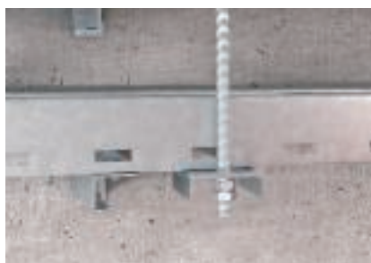
Mocowanie pionowego pręta gwintowanego na elemencie łączeniowym
