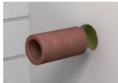
Wkładanie płaszcza rurowego do lekkiej ściany działowej
