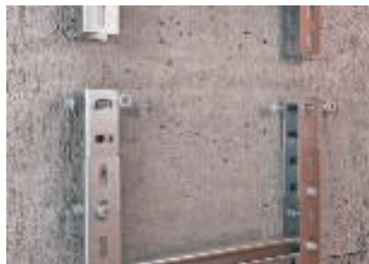
Wykonanie łączenia za pomocą przykręcanych łączników
