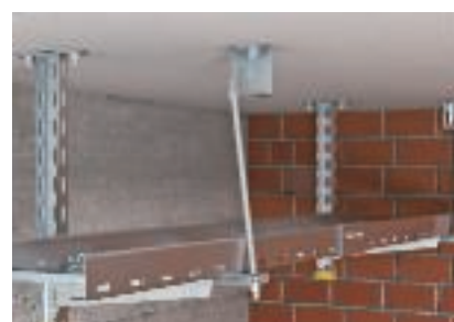
Zawieszanie pręta gwintowanego w uchwycie stropowym
