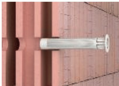
Dozwolony montaż za pomocą tulejek sitowych z tworzywa
