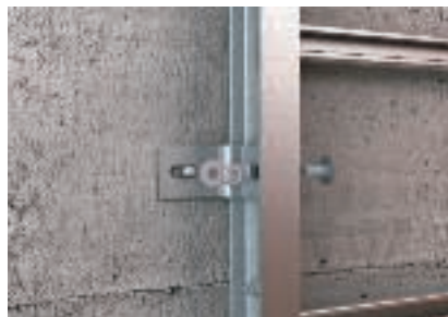
Montaż za pomocą przykręcanych kątowników mocujących
