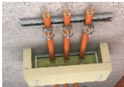
Montaż odciążenia ciągu w połączeniu z układaniem kabli na szynach profilowych
