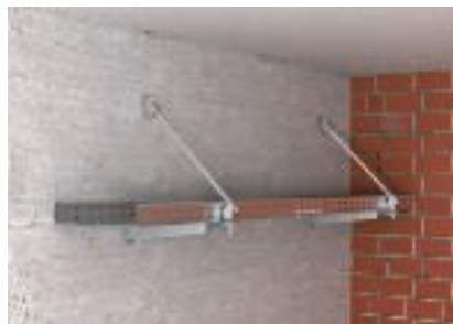
Montaż ścienny z zabezpieczeniem prętem gwintowanym skośnie
