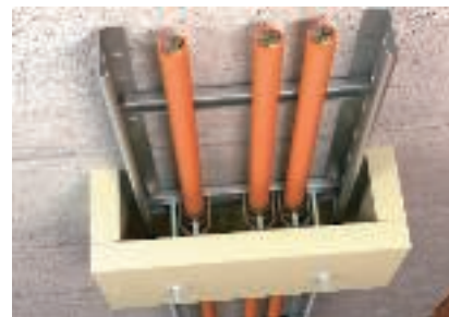
Montaż odciążenia ciągu w połączeniu z drabinami pionowymi
