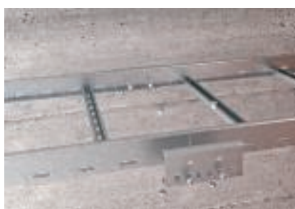
Montaż łączników wzdłużnych za pomocą śrub z łbem grzybkowym
