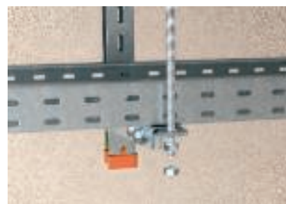
Montaż zabezpieczenia pręta gwintowanego za pomocą kątownika przyłączeniowego na końcu wspornika.
