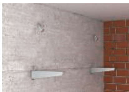
Montaż wspornika i elementów łączeniowych na ścianie
