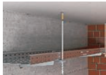
Mocowanie sufitowe prętów gwintowanych za pomocą kołków z gwintem wewnętrznym
