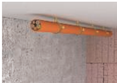
Montaż pod sufitem
