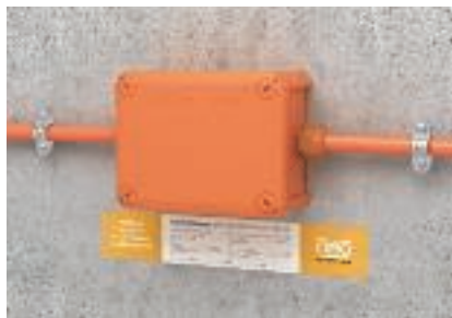
Zainstalowany FireBox z tabliczką opisową
