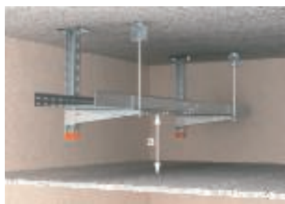
Wymagany odstęp minimalny od sufitu podwieszanego
