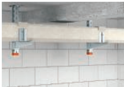
Podwieszany montaż sufitowy jako kanał I
