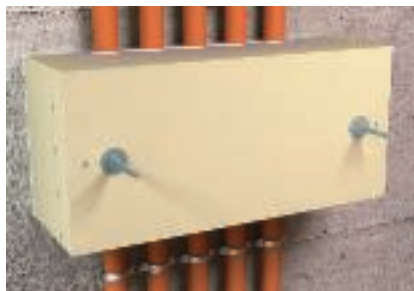
Montaż odciążenia ciągu w połączeniu z układaniem obejm pojedynczych
