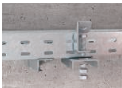
Mocowanie elementu łączeniowego skośnego
