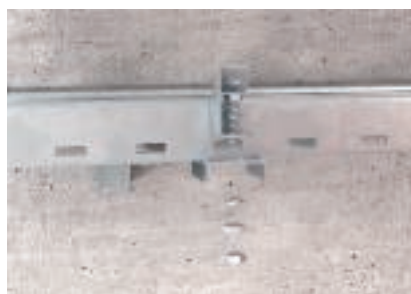
Montaż elementu łączeniowego-skośnego za pomocą śruby z łbem sześciokątnym i nakrętek sześciokątnych
