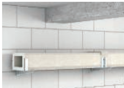
Montaż ścienny kanału I
