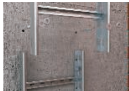
Wykonanie łączenia bez łączników
