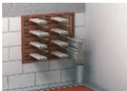
Grupowe rozmieszczenie przepustów
