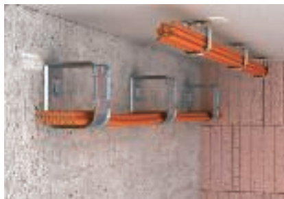
Poziomy montaż ścienny i stropowy
