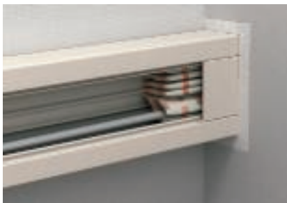
Poduszka umieszczona w kanale
