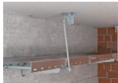
Mocowanie sufitowe prętów gwintowanych za pomocą uchwytów stropowych
