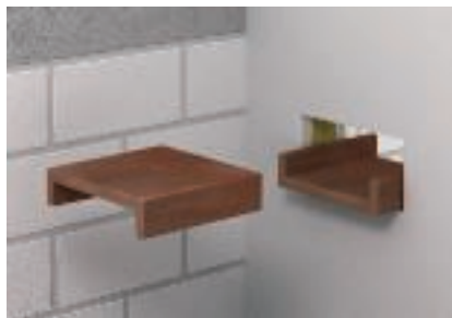
Wkładanie dzielonej ramy do lekkich ścianek działowych
