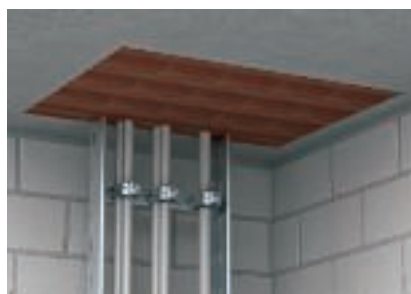
Ścisły montaż bloczków w stropie
