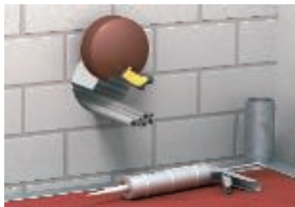
Przycięcie zatyczek przy wkładaniu kabli przy krawędzi otworu
