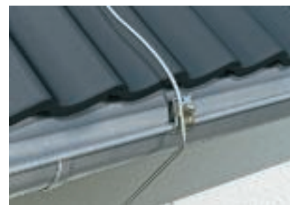
Przewód przymocowany zaciskiem rynnowym
